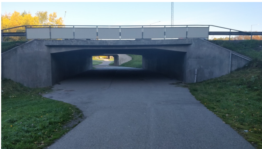
Figur 4. Befintligt gång- och cykelväg under E4 mot Fittja centrum. Stråket upplevs sannolikt av många som otryggt kvällstid pga sin ödsliga omgivning och gångtunnlar med begränsade flyktvägar.
