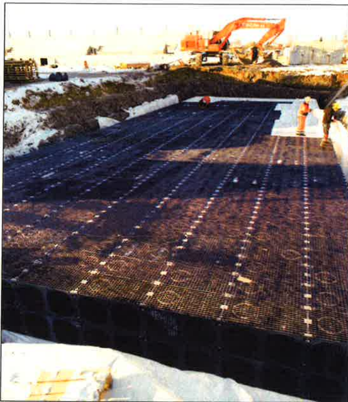
Figur 6. Exempel på utjämningsmagasin i form av dagvattenkassetter (Wavin)
