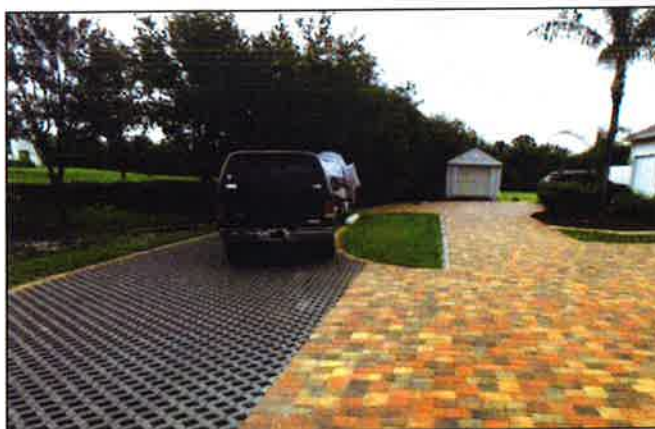
Figur 5. Parkeringsyta med hålsten i betong
