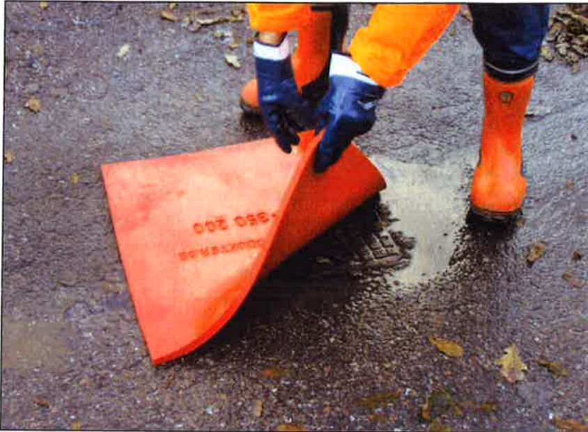
Figur 8. Exempel på brunnstättning med matta (Källa: med tillåtelse av (PK ProdukterAB, 2014))
