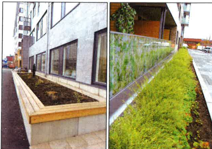
Figur 7. Rain Gardens kan bli ett grönt inslag i miljöer med stor andel hårdgjorda ytor
