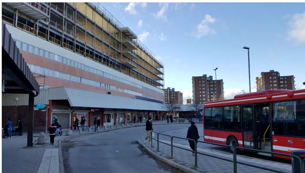
Figur 1: Pågående tillbyggnad med bostäder i Fittja Centrum
