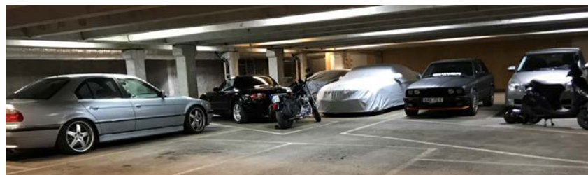
Bild: Garage med 41 p-platser under hus C
