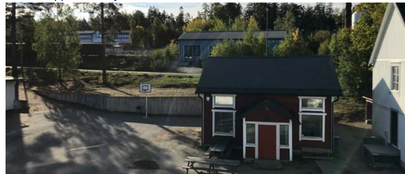
Bild: Förslag till plats för nybyggnation. Befintlig byggnad flyttas alternativt rivs.
