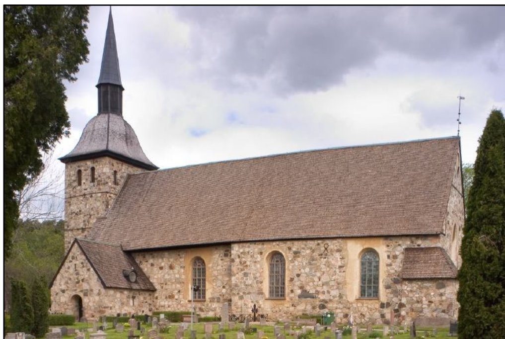
Botkyrka kyrka med sin karaktäristiska gråstensfasad, sett från söder.
