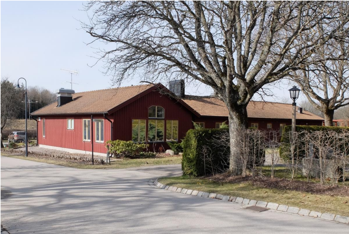
Figur 12. Den befintliga personalbyggnaden. Foto Tyréns.
