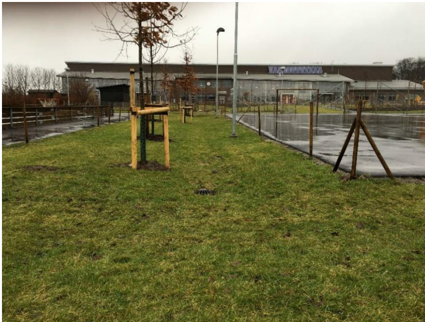
Figur 19. Svackdike med kupolbrunn (Bildkälla: Kent Fridell/SLU)
