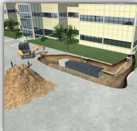
Figur 9. Exempel på dagvattenkassetter för fördröjning av dagvatten. Kan anläggas under körbara ytor (Uponor IQ, 2013)
