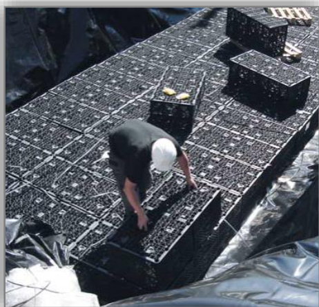
Figur 9. Exempel på dagvattenkassetter för fördröjning av dagvatten. Kan anläggas under körbara ytor (Uponor IQ, 2013)
