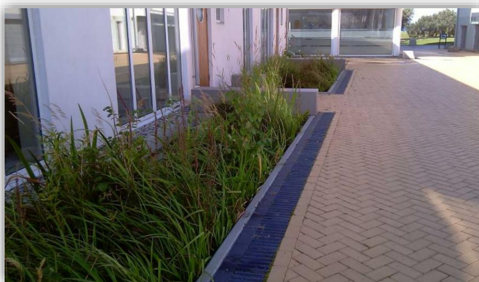
Figur 5. Regnbädd som behandlar takvatten och dagvatten från innegård. Vatten leds till regnbädden från stuprör samt ytledes från innegård genom genomsläppligt gjutjärnsgaller. (Foto: Växjö kommun)
