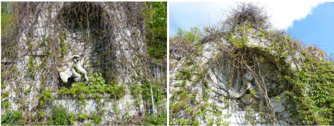
Betongfontäner med dekorativa zinkgjutna skulpturer från Bolinders mekaniska verkstad pryder mursträckan som kantar vägen utmed Gula villan.
