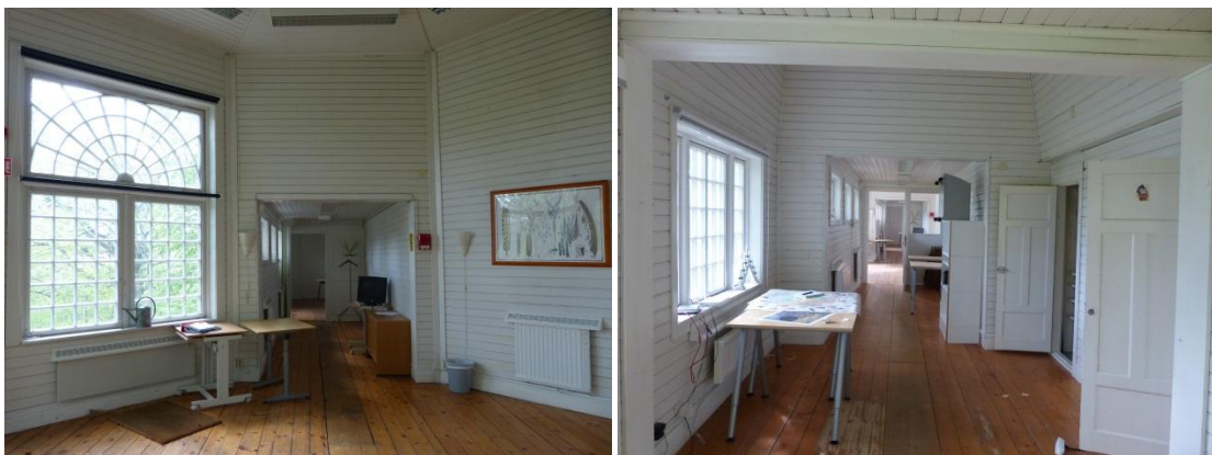
Kägelbanans interiör har i hög grad grunddragen bevarade trots viss modernisering avseende ytskikt och installationer. I furugolvet märks banornas centrala ekplanka, dansrotundans stora ljusinsläpp och högre takvolym, ljusinsläppen ligger samlade åt söder, originaldetaljer i dörrar och en del snickerier.
