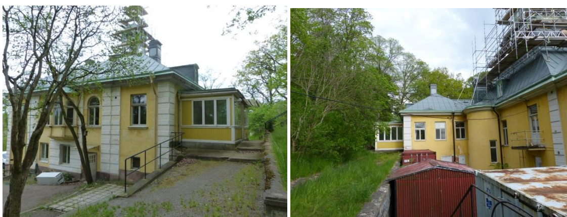
Tv. Huvudbyggnadens östfasad med burspråk och köksingång. Den tillbyggda flygeln från tidigt 1800-tal syns i gavelfasadens sockelparti och i den medvetet dubblerade rusticeringen. Flygeln ansluter till ursprungsarkitekturen i både fasad och taksiluett. Innan den anslutande glasverandan tillkom på 1920-talet anslöt flygeln med utgång direkt till bergryggens slänt mot trappan till kägelbanan.
