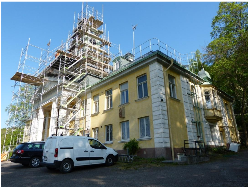
Huvudbyggnadens entréfasad från öster med det centralt markerade mittpartiet dolt bakom byggnadsställningar för pågående takomläggning.
