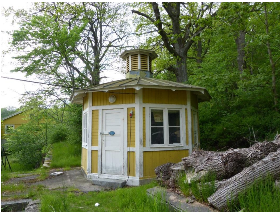
Lusthuset som ursprungligen fungerade som utedass med fyra separata ingångar. Dagens fönstersättning är sannolikt ett resultat av ändrad användning till lusthus i början på 1900-talet.
