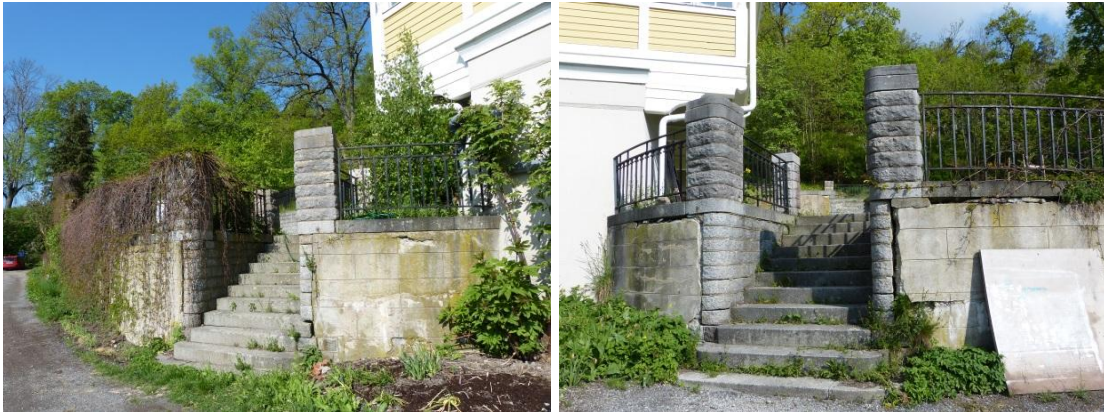
Trädgården möter mot vägen med symmetriskt placerade trappor i den dekorativa muren av natursten, betong och smide.
