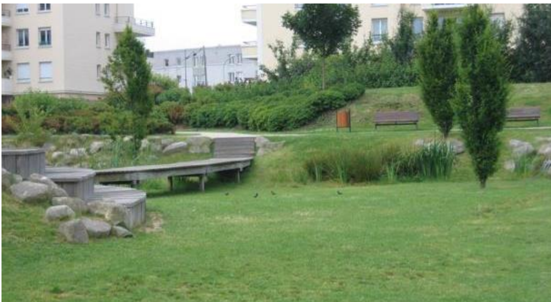
Figur 11. Exempel på yta avsedd för flödesutjämning. Vid mindre regn är ytan till största delen torr och kan rena dagvatten genom infiltration. Vid store regn fylls ytan med vatten.
