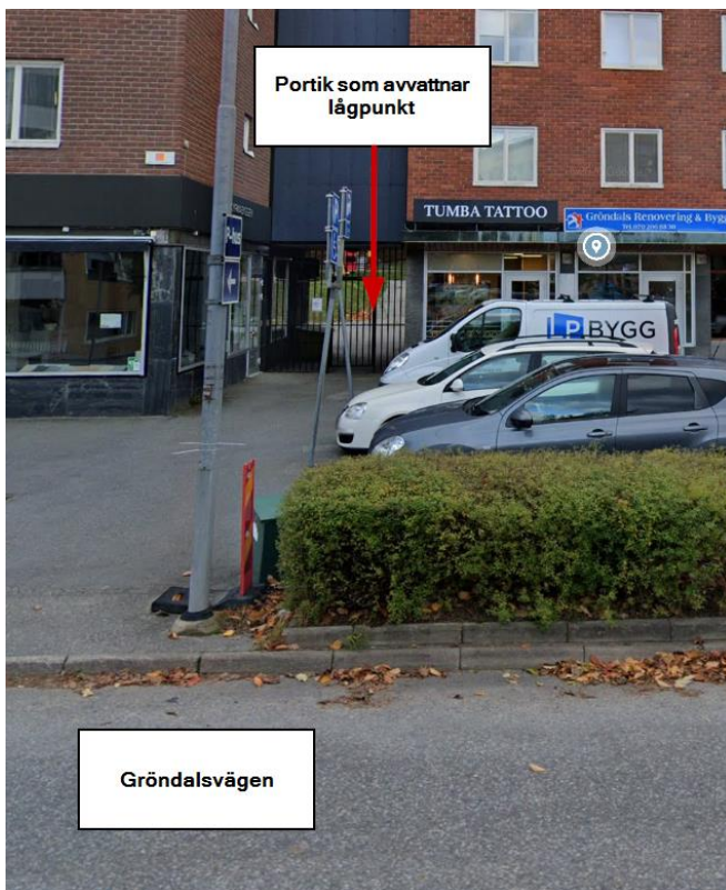
Figur 7. Portik som avvattnar lägpunkten på innergården (Bild från Google 2021-10-15).
