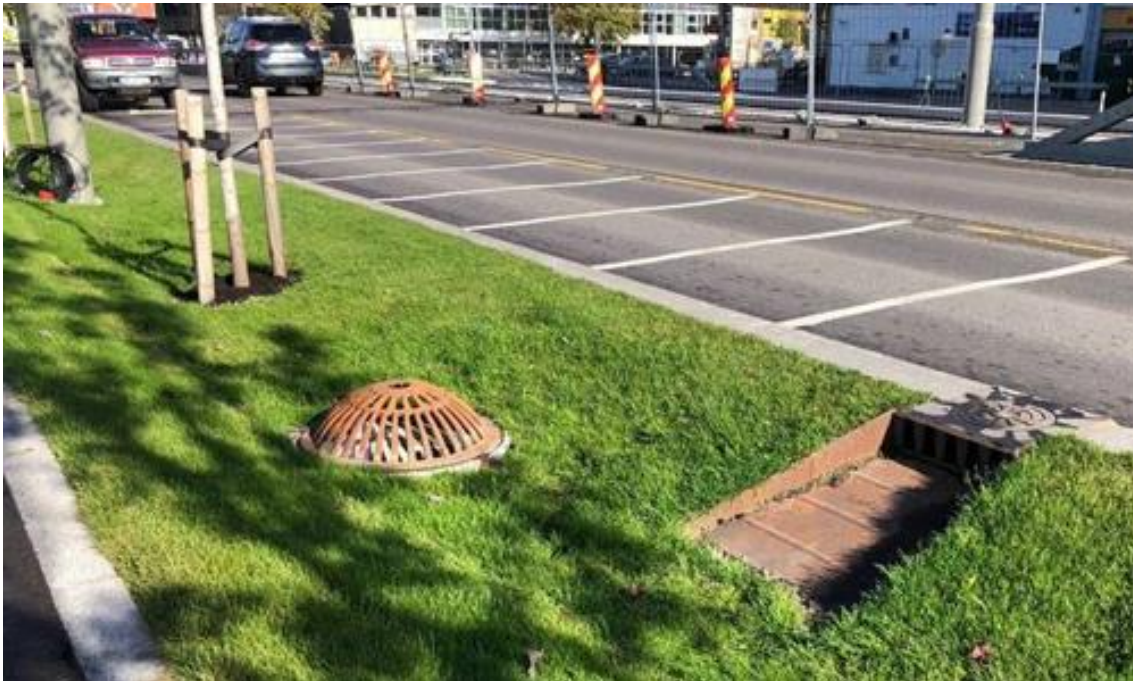
Figur 12. Exempel på ett svackdike för rening av dagvatten, via infiltration, upp till viss nivå. Vid större regn sker flödesutjämning. Brunnen dimensioneras enligt önskat utflöde.
