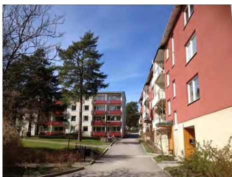
Lamellhus norr om planområdet
