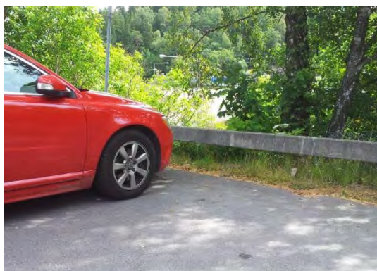
Foto 6.2 Inga kantstenar runt parkeringsplatsen så att dagvattnet kan tas omhand i det omgivande grönområdet, Tumba.
