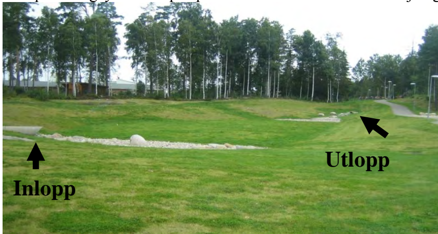
Foto 6.4 Fördröjningsmagasin som används om det regnar mycket, övriga tider är det en plats för lek och rekreation. Växjö kommun.
