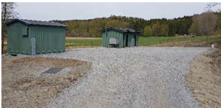
Pumpstation, tryckstegring och opto Wallen
