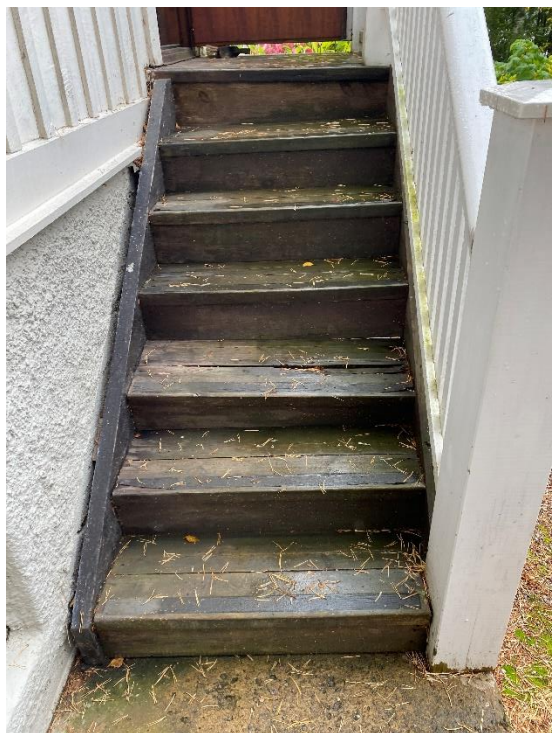
Bild 1 - Entrétrappa Bullriga huset
