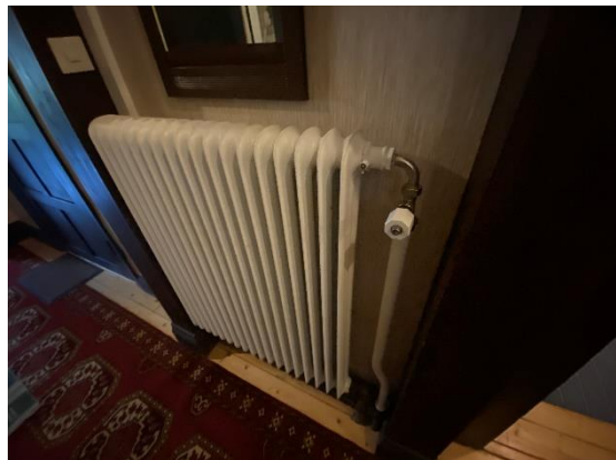
Bild 20 - Äldre sektionsradiator
