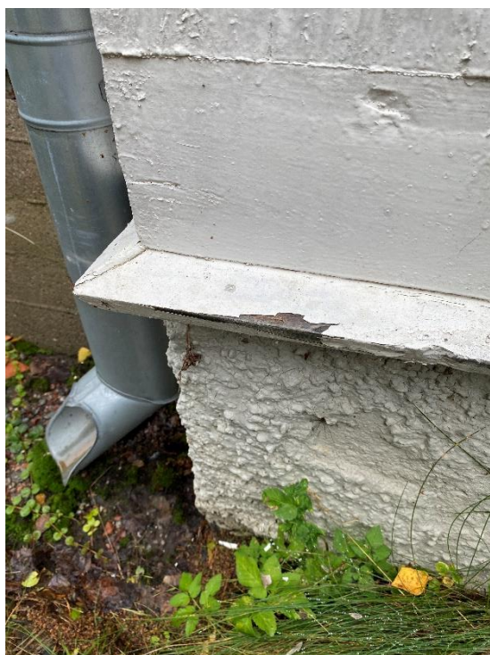
Bild 4 - Nedre fasadlist huvudbyggnad
