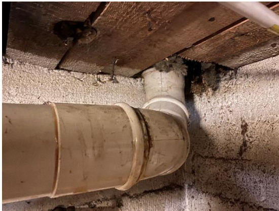
Bild 17 - Avloppsrör bytes i samband med renovering WC
