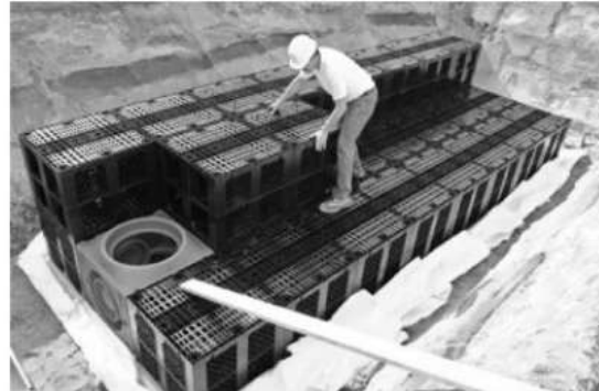
Figur 18: Typsektion krossfyllt magasin med överbyggnad, dagvattenkassetter.
