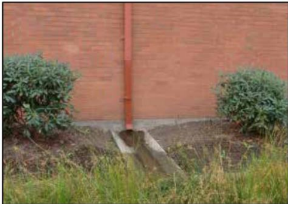
Figur 6-2. Exempel på utformning av avledning av takdagvatten via stupsröskastare och rännal (t.v.). Till höger visas ett exempel på hur rännal i gatsten kan nyttjas för gestaltning av innergård.
