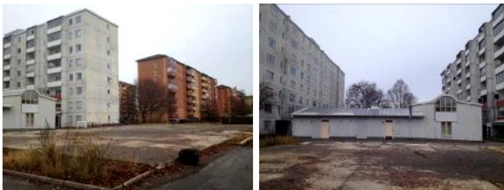
Befintlig bostadsbebyggelse i åttavåningar.
