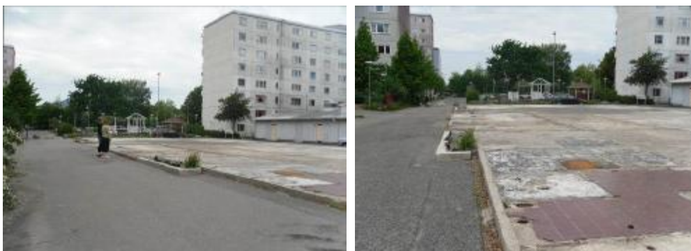
Vy från sydöst. I bakgrunden förutom det åttavåningshuset syns lekplats och bakom lekplatsen en parkering.
