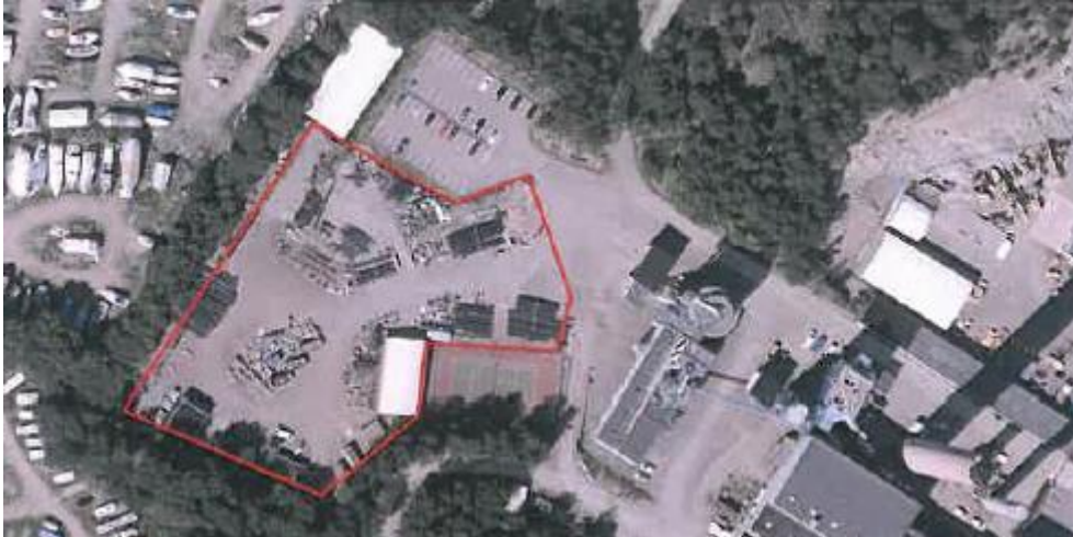
Figur 4.2. Område närmast planområdet där lastning, lossning och bearbetning av rör sker.
