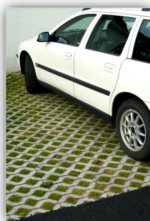
Bild 4. Gräsarmering till parkeringsytor (S:t Eriks 20170127)
