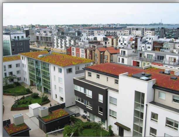
Bild 3. Grönt tak eller sedumtak ( Veg Tech 17-01-30 )
