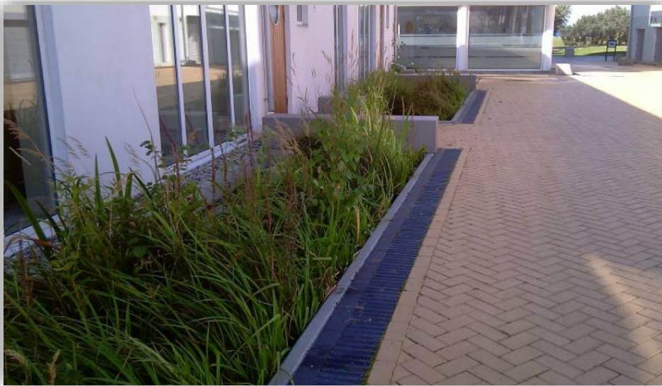
Bild 6. Regnbädd som behandlar takvatten och dagvatten från innegård. Vatten leds till regnbädden från stuprör samt ytledes från innegård genom genomsläppligt gjutjärnsgaller. (Foto: Växjö kommun)
