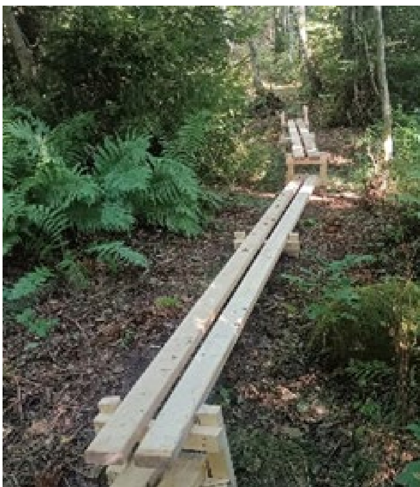
Nylagd spång på Saltbergsstigen. Foto: Jonathan Kearny.
