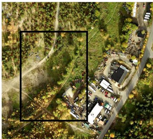
Befintlig slänt i sydvästra delen av området, källa Geoteknisk PM.
