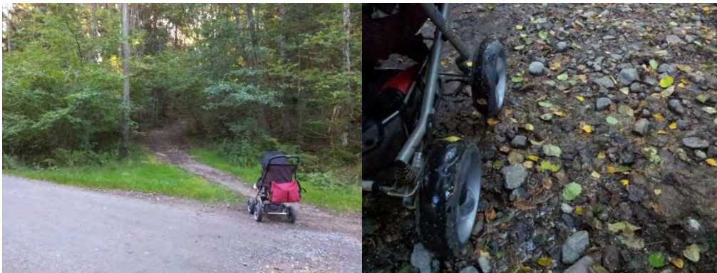
Vägsträckans anslutning till Stendalsvägen är delvis gräsbeväxt (vänster). Grovt underlag (höger)
