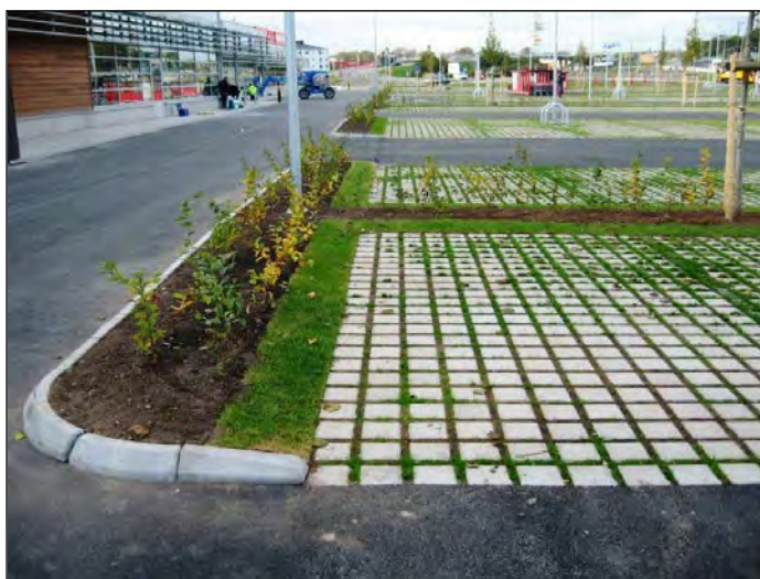
Parkeringsyta med genomsläpplig beläggning
