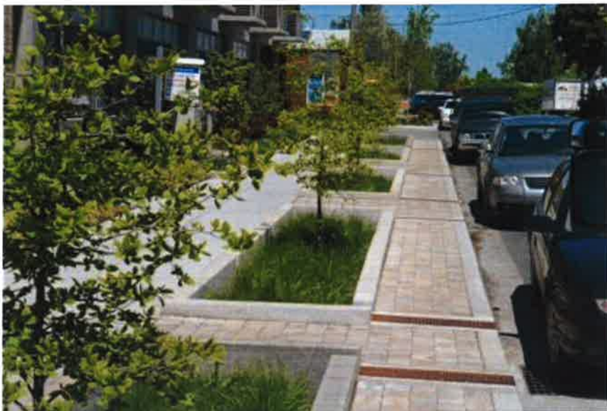
Figur 4. Exempel på dagvattenrännor som kan anläggas för att leda vatten från vegetationsytor till brunnar. Samma princip kan användas för att leda dagvatten från en vegetationsyta till en annan, över hårdgjord yta. Portland, USA.
