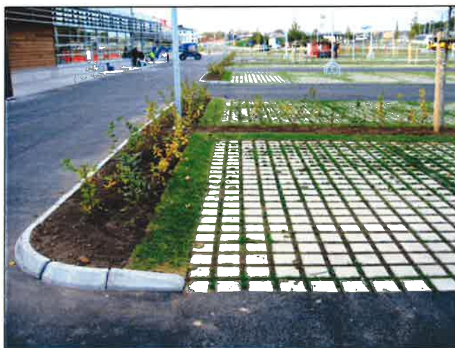
Parkeringsyta med genomsläpplig beläggning
