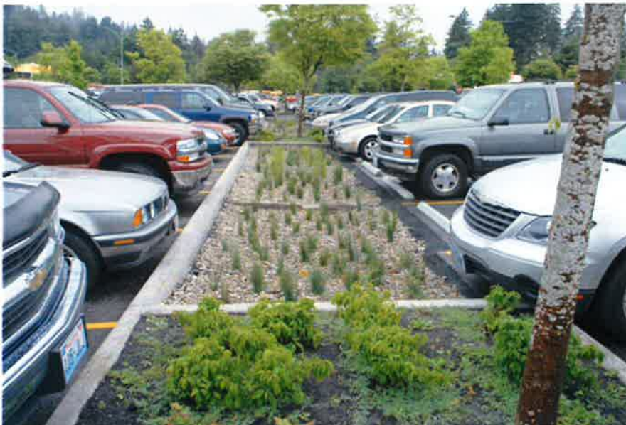
Figur 6. Fördröjning/infiltrationsytor för dagvatten från parkeringsytor, Portland USA.
