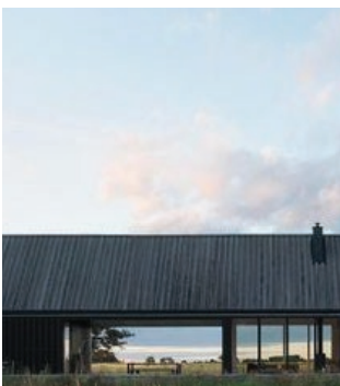
SIKT GENOM BYGGNAD
