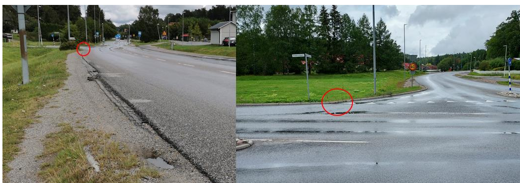
Figur 3-8 TV: Nibblevägen blickandes nordöst med mottagande dagvattenbrunn inringad där vägdiket i vänstra delen av bilden sannolikt inte tar emot vägdagvatten från Nibblevägen. TH: Korsning Nibblevägen/Nibblebacken blickandes upp mot Nibblebacken (nordväst) med inringad mottagande dagvattenbrunn.
