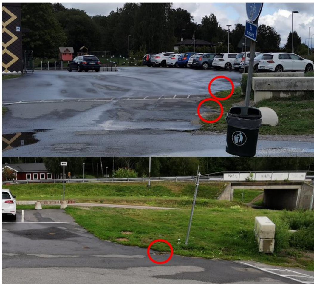
Figur 3-7. Dagvatten från bilparkeringen avrinner direkt till dagvattenbrunnar inom planområdet.
