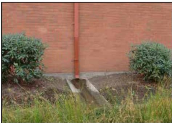
Figur 6-2. Exempel på utformning av avledning av takdagvatten via stuprörsutkastare och ränndalar (t.v.). Till höger visas ett exempel på hur ränndalar i gatsten kan nyttjas för gestaltning av innergård.
