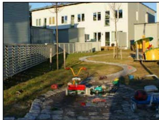
Figur 6-2. Exempel på utformning av avledning av takdagvatten via stuprörsutkastare och ränndalar (t.v.). Till höger visas ett exempel på hur ränndalar i gatsten kan nyttjas för gestaltning av innergård.
