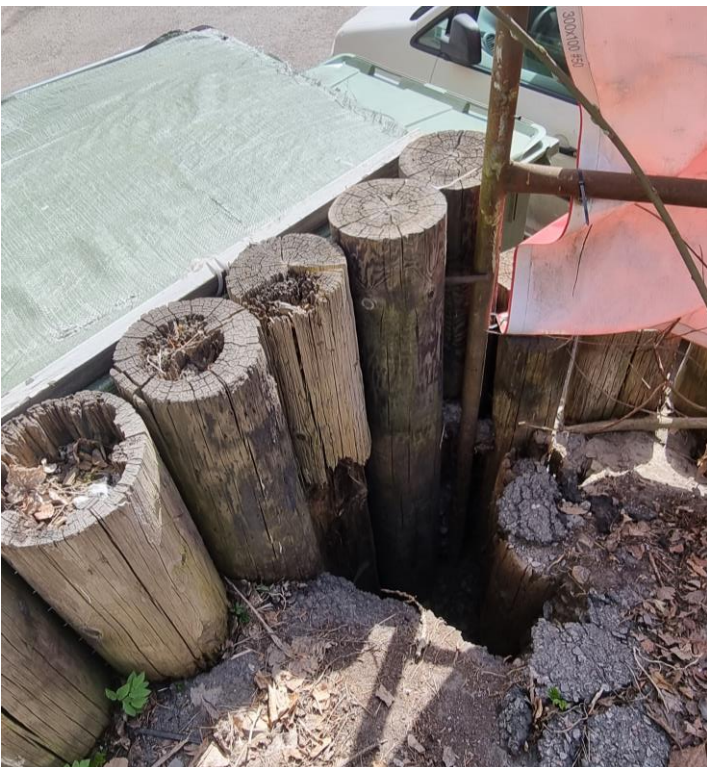
Figur 9 Stödmuren bakom parkeringen, däckverkstadens västra sida.
