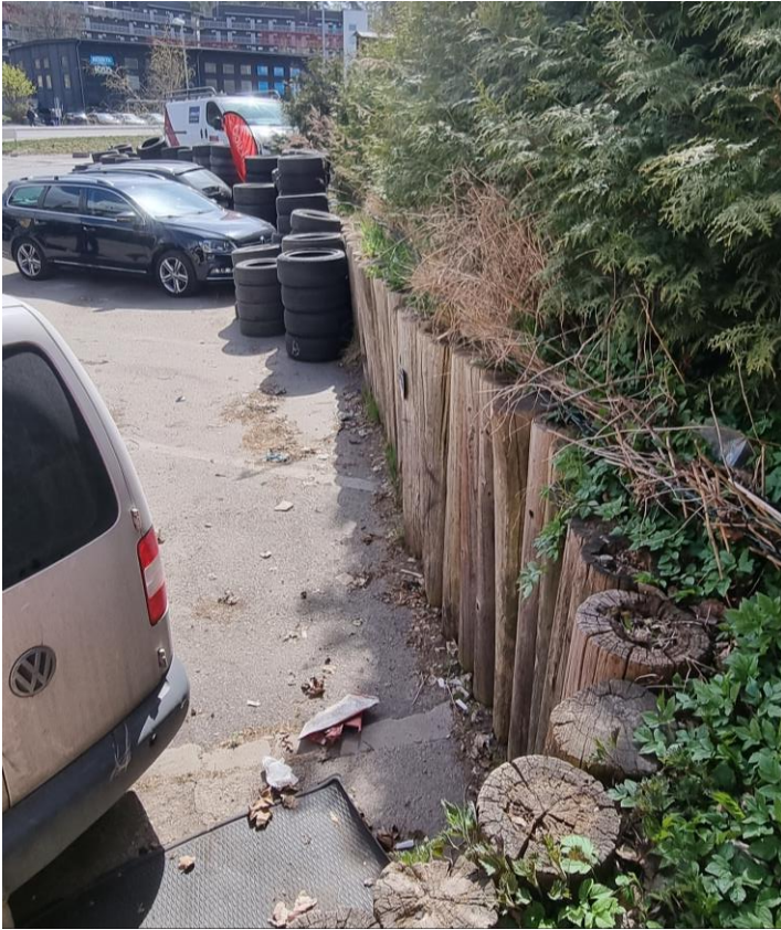
Figur 8 Stödmuren bakom parkeringen, däckverkstadens västra sida.
