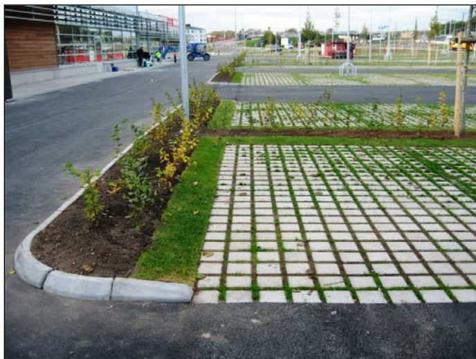
Parkeringsyta med genomsläpplig beläggning
