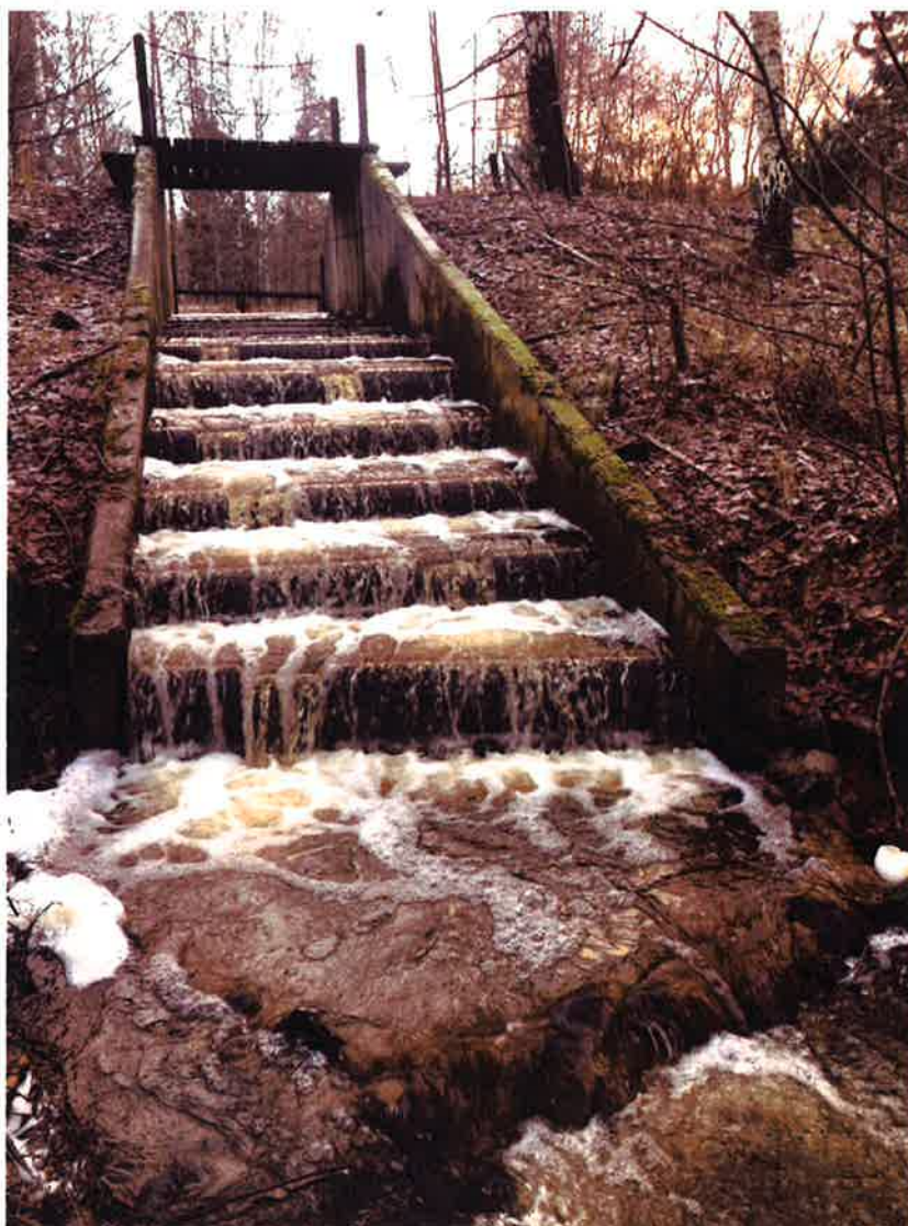
Nygjord fisktrappa nedströms branddamm i Harbrobäcken, december 2018.
