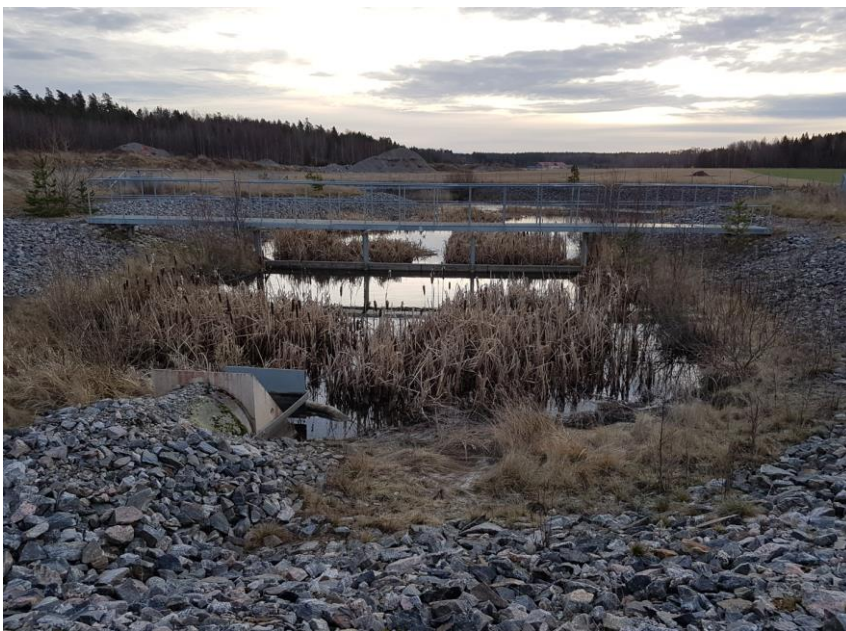
Figur 9 – Bild över den befintliga dammen, vy söderut (bild Tyréns 2020).
