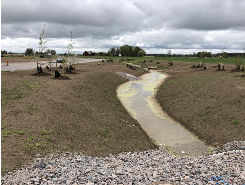
Figur 13 – Exempel på uppsamlande dike med lägre gestaltningsnivå från exploateringsområde i Bankeberg, Linköping (Boberg 2020). Bilden tagen strax efter utbyggnad.
