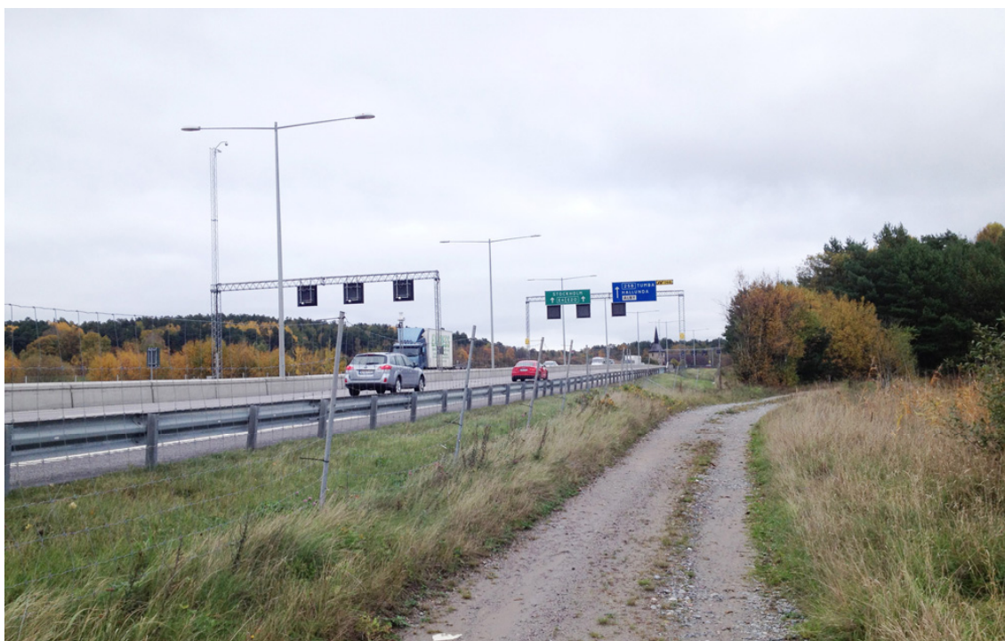
Fotomontage 3. Vy från punkt vid E4/E20 mot Botkyrka kyrka. Notera den bullerskärm som föreslås vid vägporten samt det bullerskydd som föreslås på befintlig bullervall.
