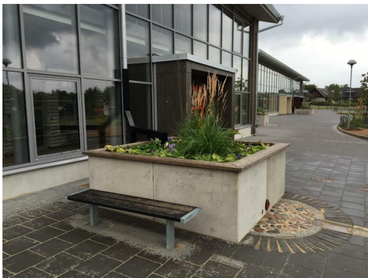
Figur 21. Växtbädd för rening och fördröjning av takvatten (Bildkälla: Kent Fridell)
