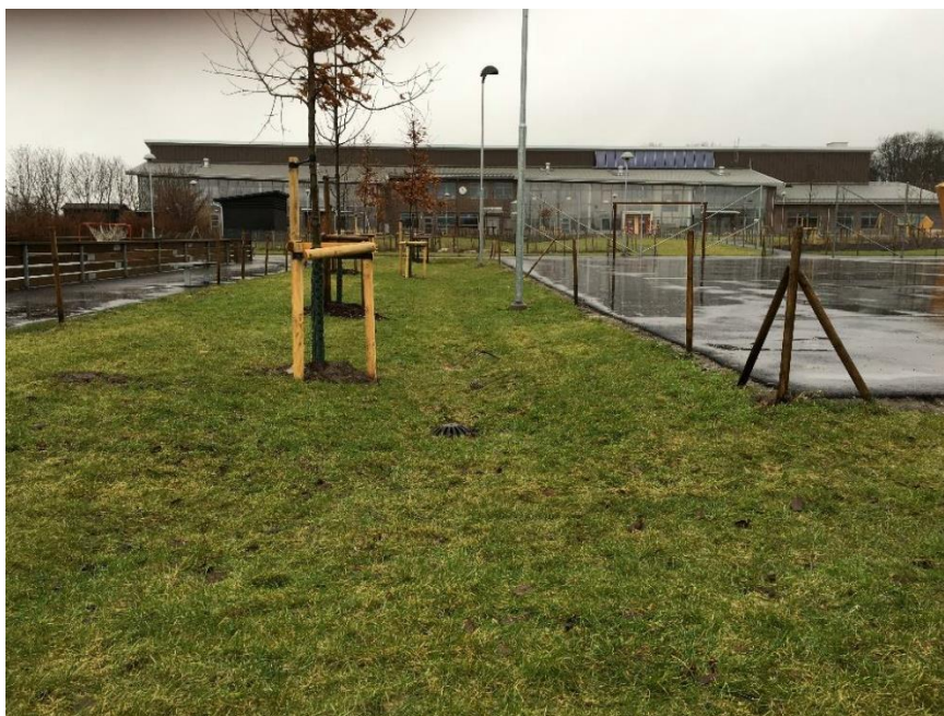
Figur 22. Svackdike med kupolbrunn (Bildkälla: Kent Fridell/SLU)
