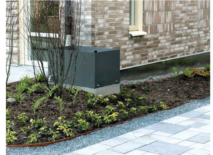
Regnskördartunna kan användas för att samla upp takvatten och leda vatten vidare till planteringsytor eller användas till odling, Nola.
