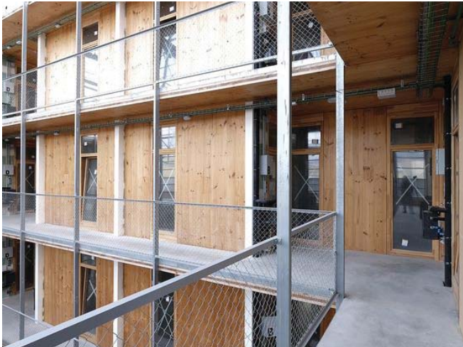
Öppna entrébalkonger med varma material i fasad Ref: Cooperativa d'habitatge La Borda, Barcelona, Spanien
