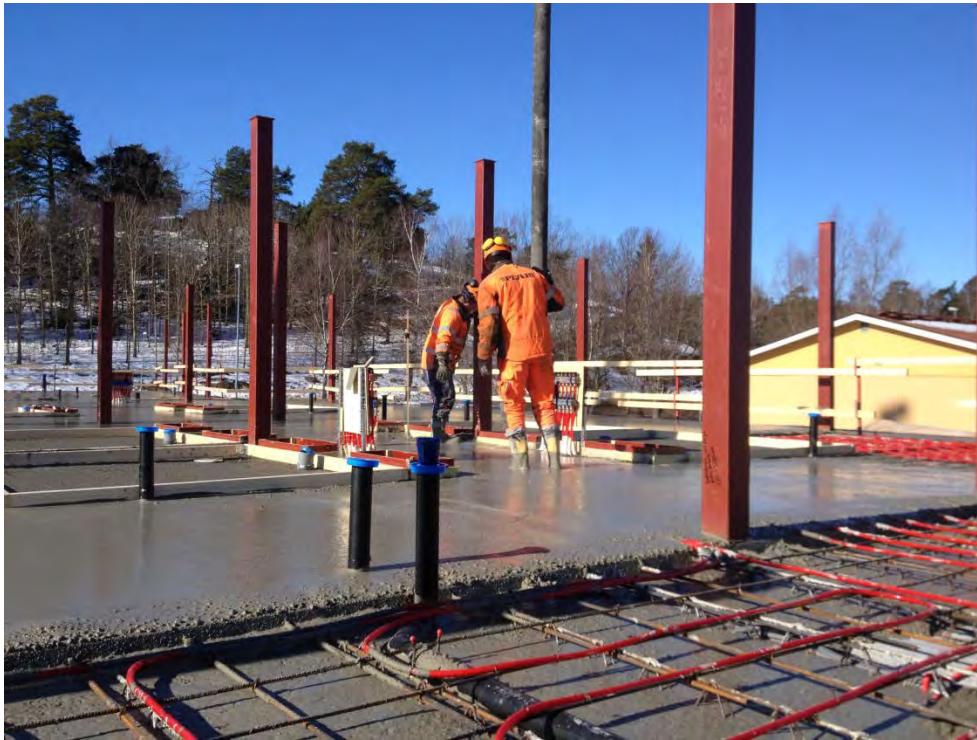
Bild från gjutning av bjälklag i mars 2013.
