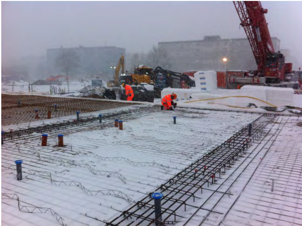
Bild från armering innan gjutning av grund i december 2012.
