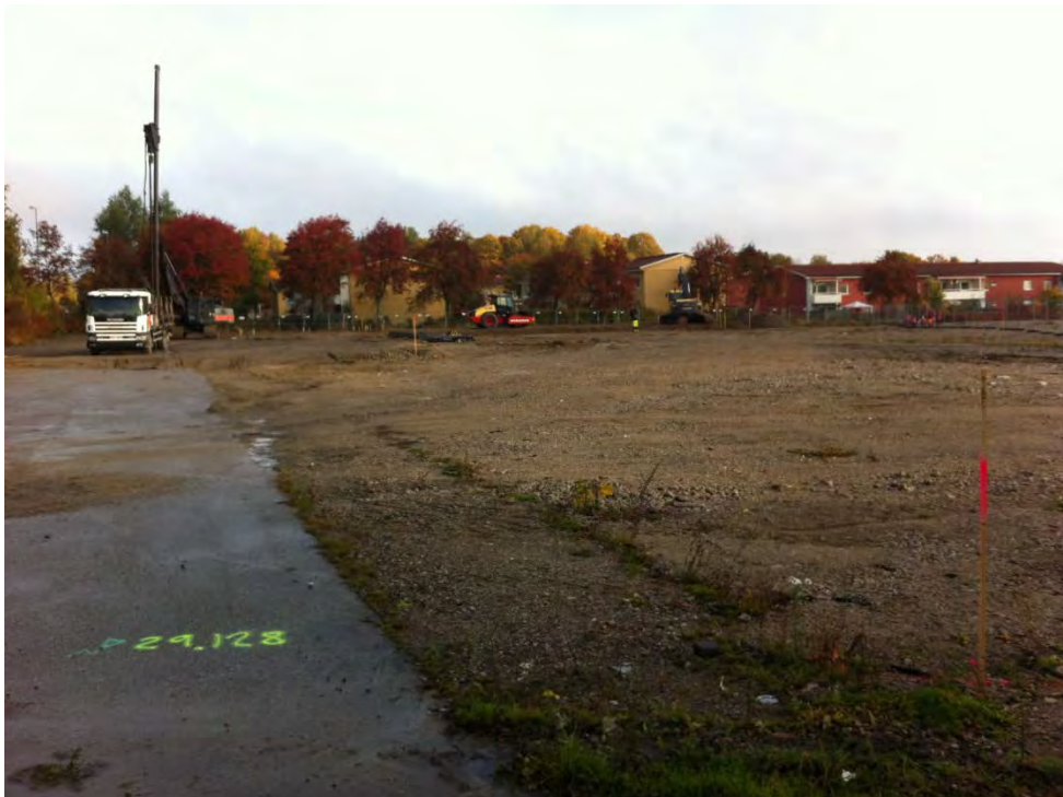
Bild från tomten i samband med att pålning påbörjades i oktober 2012.
