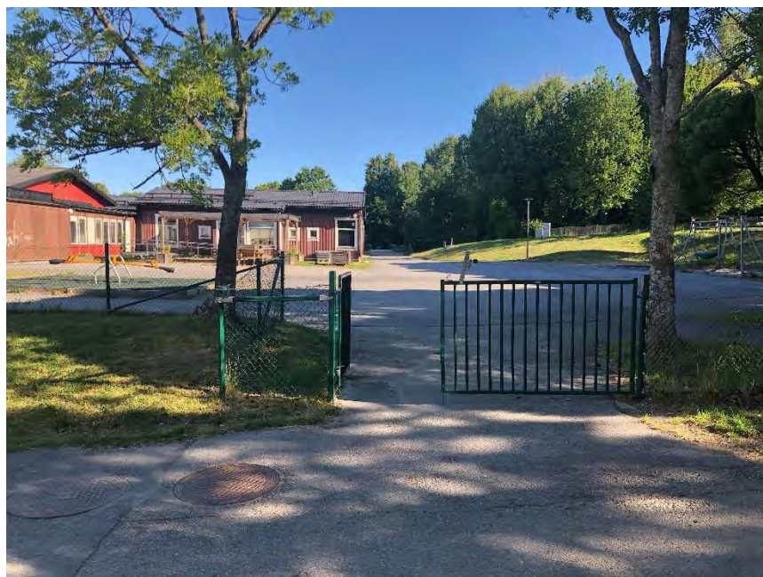
Figur 4 – Befintlig förskola från sydöst.
