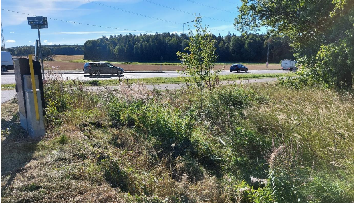
Figur 3-7. Områdets nordöstra hörn där Kumla gårdsväg möter Hågelbyvägen med igenväxt svackdike i bild. Fotografi taget i östlig riktning.
