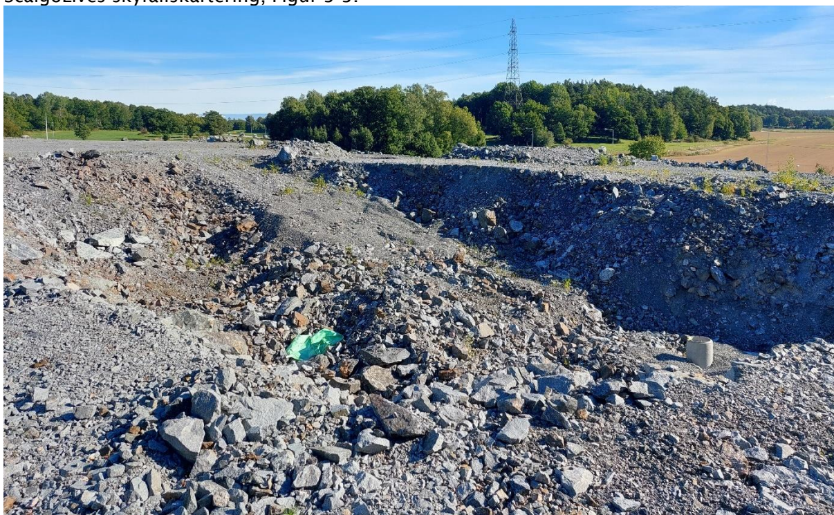
Figur 3-3. Lokal grop mitt i fastigheten. Fotografiet taget i nordöstlig riktning.
