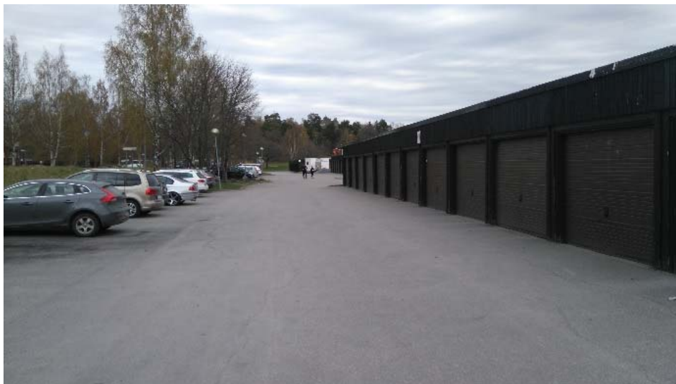
Vy från syd mot befintligt angöringsplatsen och parkering.
