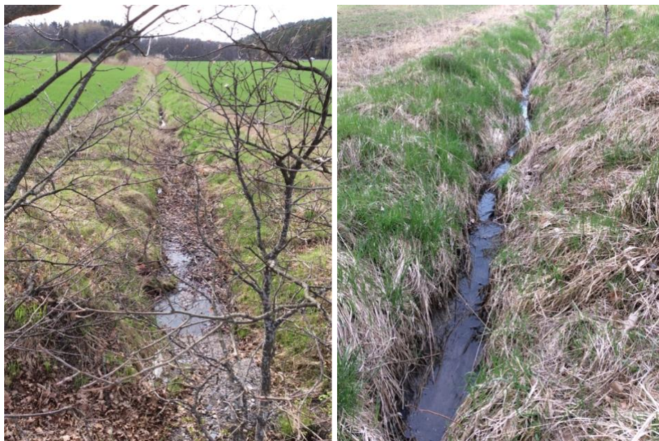
Figur 2. Diket genom åkermarken. Till vänster diket varav delar är fylld med löv och gräs, längre bort igenväxt med vass och buskage. Till höger en mer öppen del av diket.
