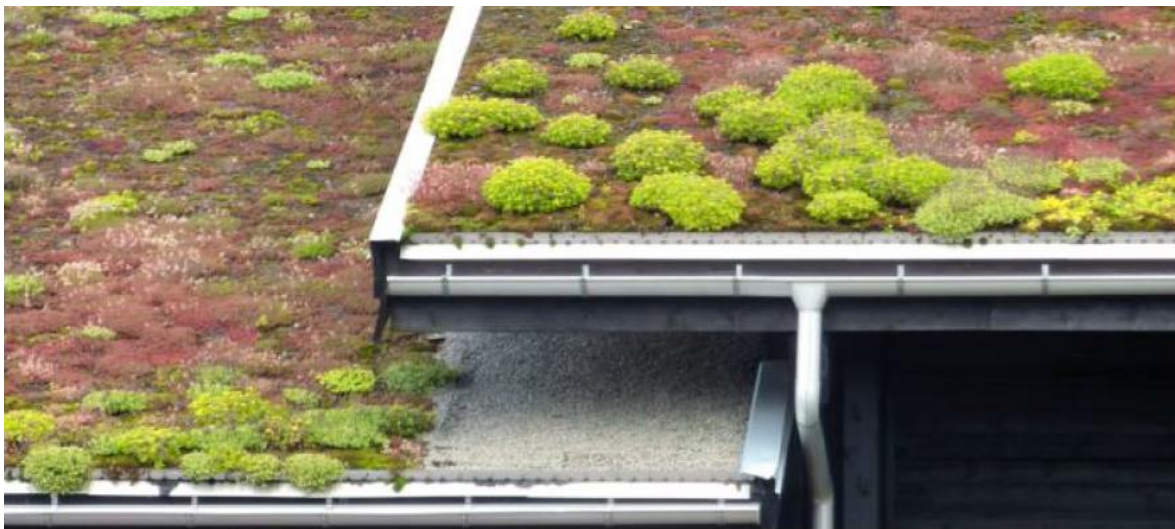
Figur 19. Exempel på ett vegetationsklätt sedumtak (Stockholm Vatten och Avfall samt WRS, 2017).
