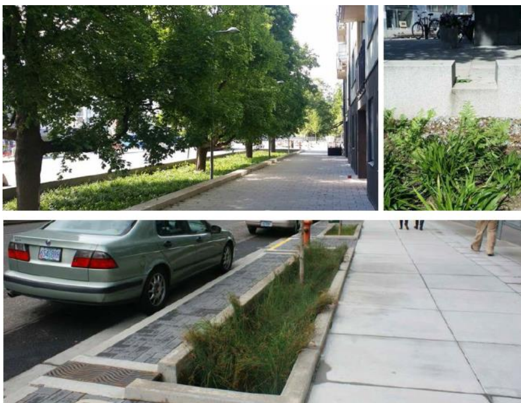
Figur 16. Exempel på en nedsänkt växtbädd eller biofilter i gatumiljö från Norra Djurgårdsstaden och Portland (SWECO och LTU, 2015).
