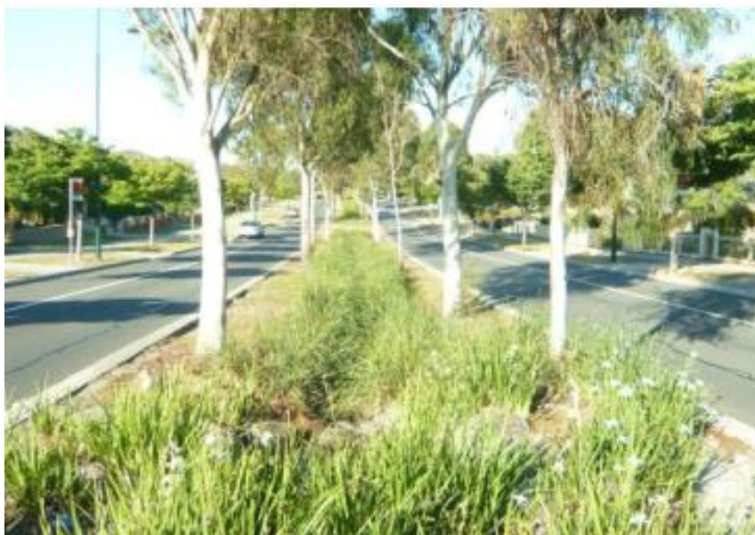
Figur 15. Exempel på trädplantering i skelettjord för omhändertagande av vägdagvatten. Trädplanterings mitt har även en funktion av svackdike vid höga flöden
