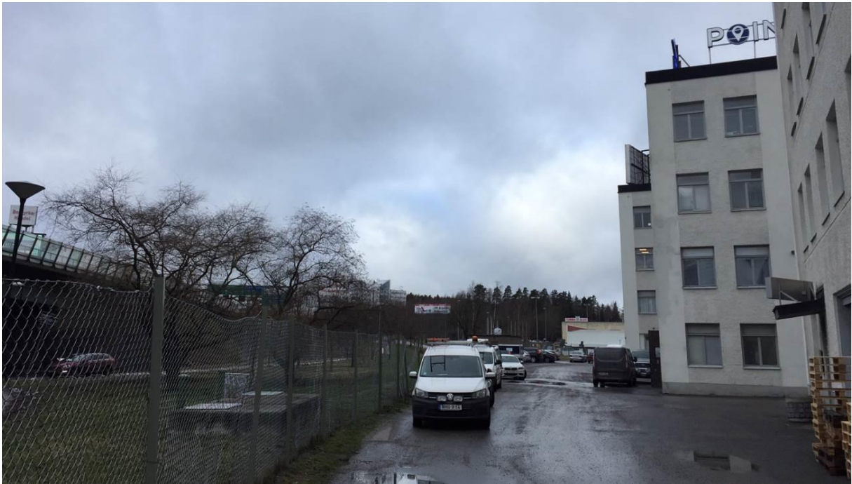
Figur 7. Vy från fastigheten Varvet 1 mot E4/E20
