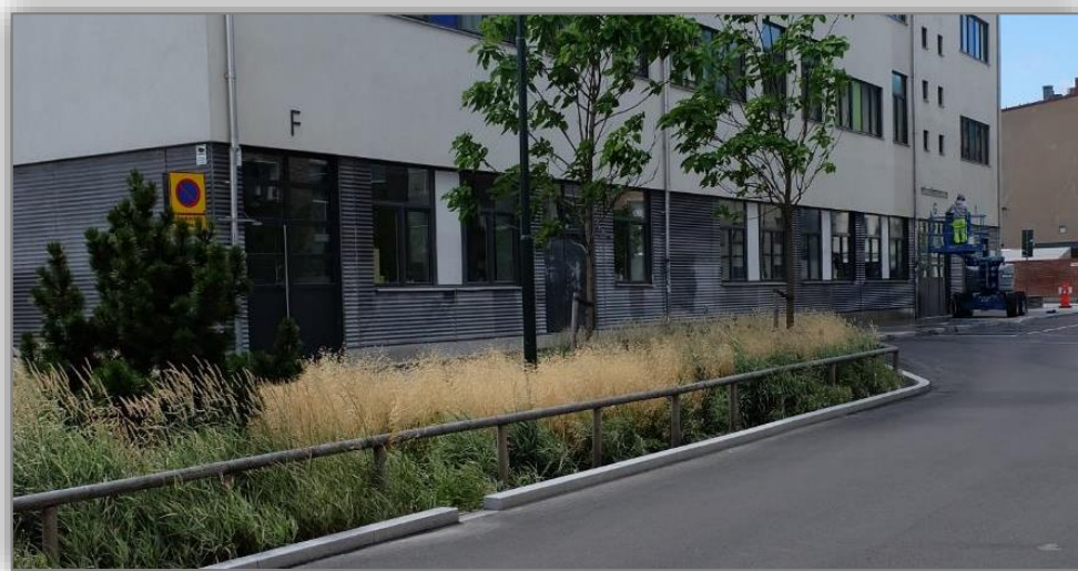
Bild 5. Regnbädd som avvattnar lokalgata och gångyta. Insläpp för ytledes avrinnande dagvatten görs i kantsten som omgärdar regnbädden (Foto: Tyréns AB, Oket i Malmö)
