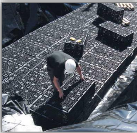
Bild 11. Exempel på dagvattenkassetter för fördröjning av dagvatten. Kan anläggas under körbara ytor (Uponor IQ, 2013)
