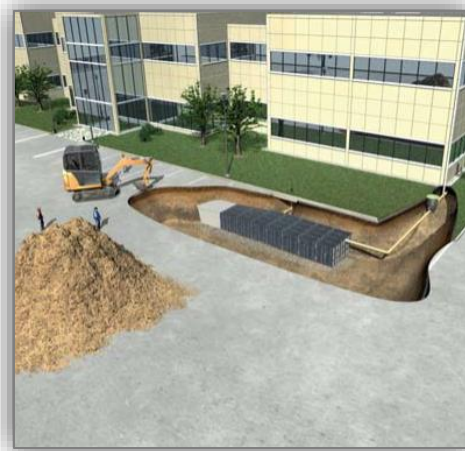
Bild 11. Exempel på dagvattenkassetter för fördröjning av dagvatten. Kan anläggas under körbara ytor (Uponor IQ, 2013)
