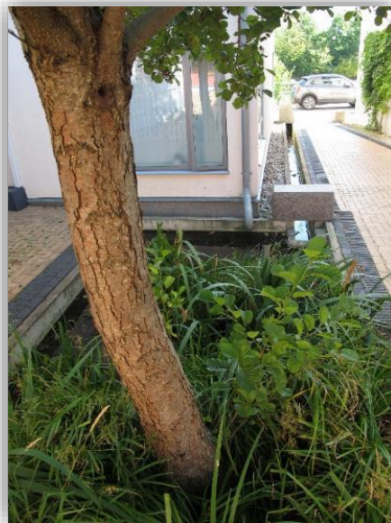
Bild 10. Exempel på dagvattenränna som transporterar dagvatten längs en husfasad. Dagvattenrännan avleder vatten från en anlagd regnbädd, både från regnbäddens dräneringsledning och vid höga vattennivåer. (Foto: Tyréns AB, från kv. Bo01, Malmö)
