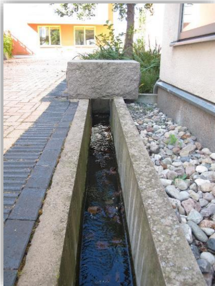
Bild 10. Exempel på dagvattenränna som transporterar dagvatten längs en husfasad. Dagvattenrännan avleder vatten från en anlagd regnbädd, både från regnbäddens dräneringsledning och vid höga vattennivåer. (Foto: Tyréns AB, från kv. Bo01, Malmö)
