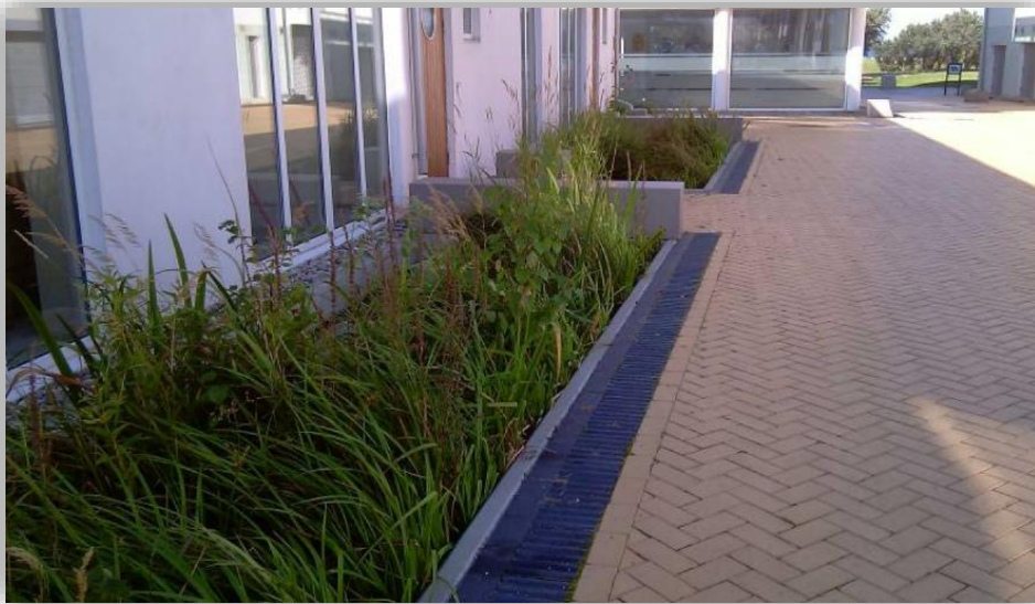
Bild 6. Regnbädd som behandlar takvatten och dagvatten från innegård. Vatten leds till regnbädden från stuprör samt ytledes från innegård genom genomsläppligt gjutjärnsgaller. (Foto: Växjö kommun)
