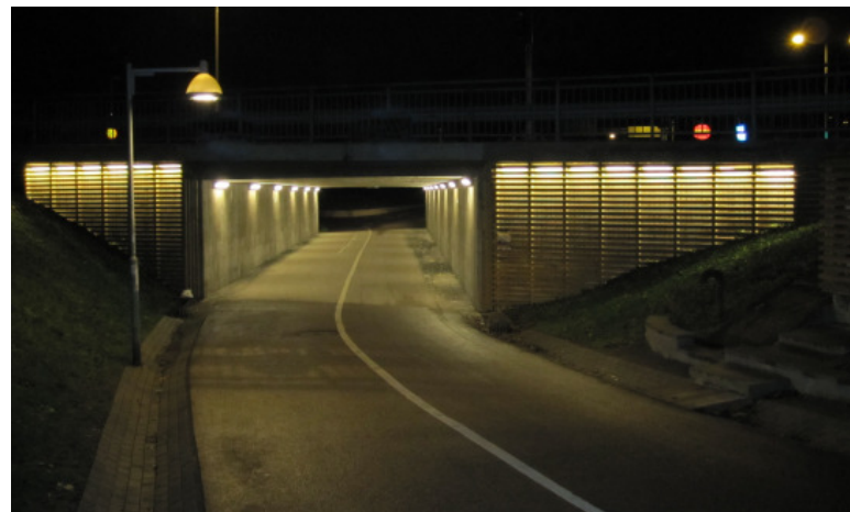
Genom att ge ljussättning på utsidan av gångtunnlar utjämnas kontrasten mellan insidan och utsidan.
