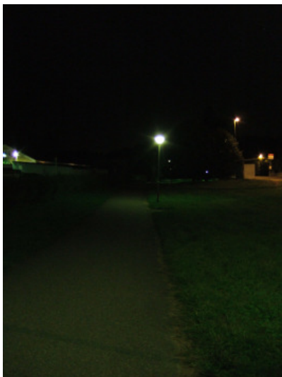
Befintlig bländande "Kineshatt" som ger dåligt med ljus på marken
