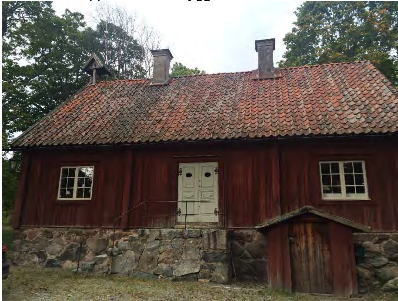
Bild 24: Klockhusets södra fasad (foto Sofia Didrik)
