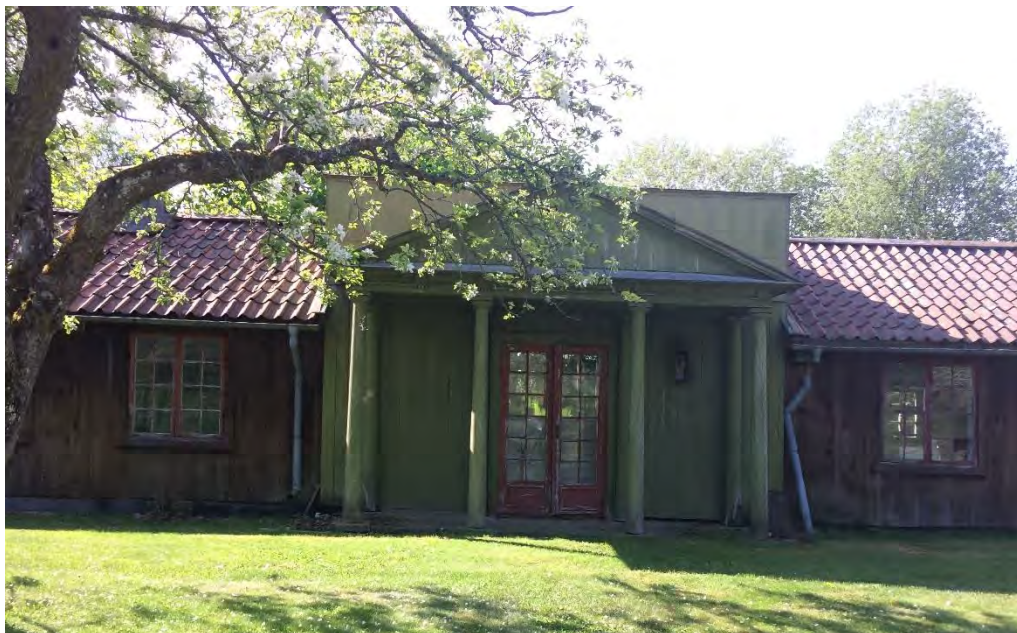
Bild 25: Orangeriets norra fasad (foto Sofia Didrik)
