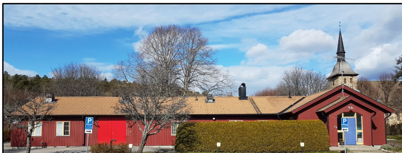
Driftbyggnaden med personalutrymmen, uppförd på 1960-talet, vy mot norr.
