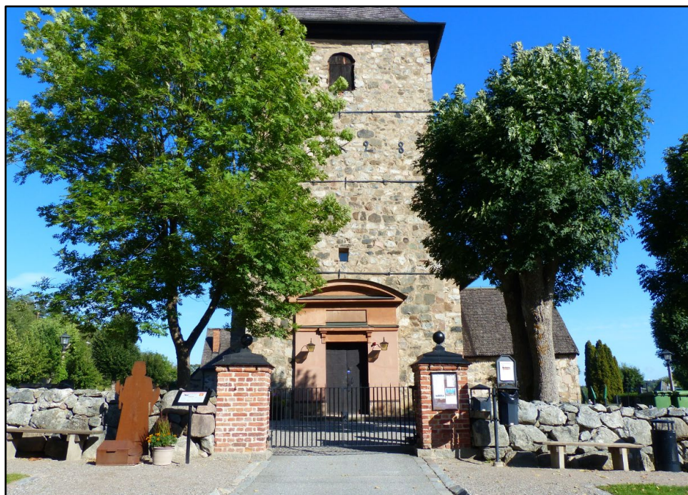
Bild på kyrkans västtorn. I förgrunden skymtas bogårdsmuren med sin gråstenstenskaraktär.
