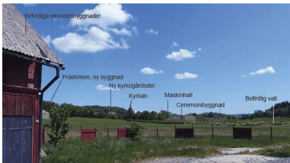
Montagebild sett från siktlinjen mellan kyrkan och Hammarby f.d. prästgård, vy mot öster. Planförslagets bedöms medför måttliga negativa konsekvenser sett till det öppna landskapet mellan kyrkan och den f.d. prästgården. Samtidigt bedöms ny bebyggelse inte påverka kulturhistoriskt viktiga och utpekande siktlinjer. Utdrag från illustrations-PM (Bjerking 2021-11-18)
