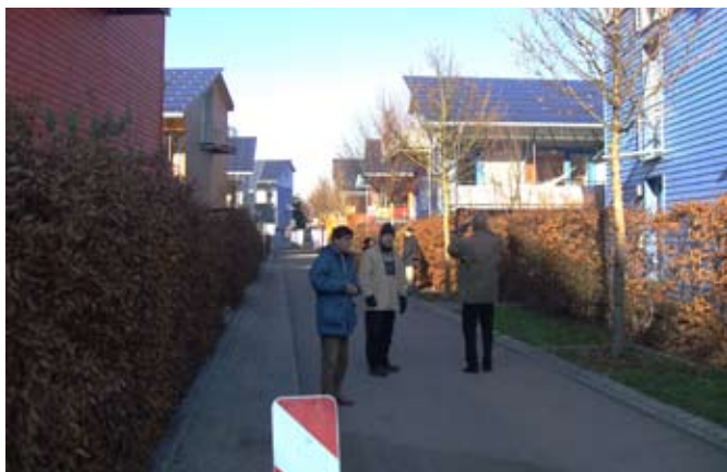
Schlierberg, Freiburg. Område med +-energibus. Den överskottsenergi som produceras genom solcellerna på taket exporteras till stadens elnät.
