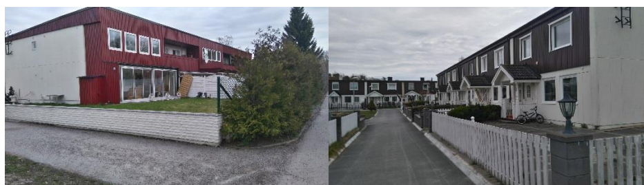
Bild 5 och 6: Vy från gång-och cykelväg mot nordväst. Vy mot innergården.
