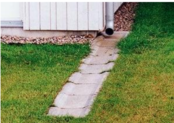
Figur 13: Exempel på stuprörsutkastare och avledning på ränndalsplattor till en infiltrationsyta från Nacka kommun (Nacka kommun, 2023).
